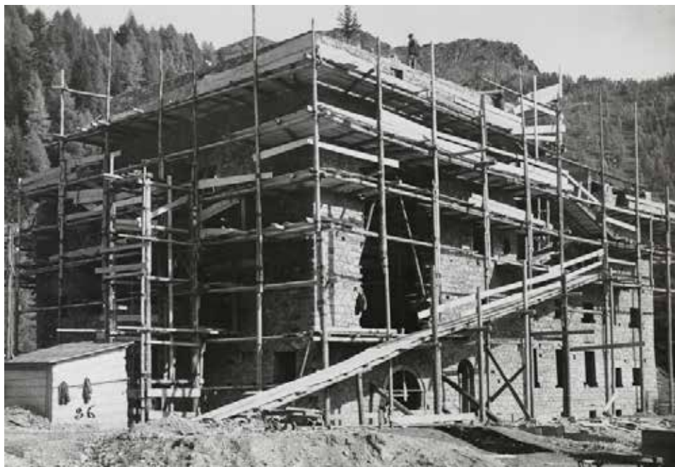
La centrale di Cavaglia in costruzione nell'ottobre del 1926. Sfrutta le acque del lago di Palù e del lago Bianco. I macchinari installati all'interno dell'edificio vengono fatti passare attraverso la grande apertura sulla facciata sud.
