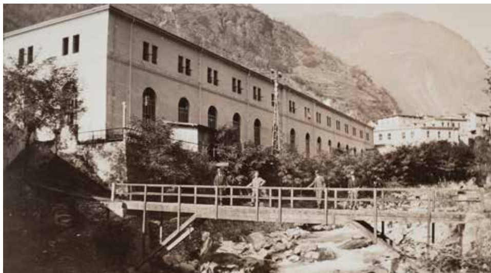
La centrale di Campocologno nel 1910. Ai tempi è la più grande centrale idroelettrica ad alta pressione in Europa, degna di ammirazione a livello internazionale.
