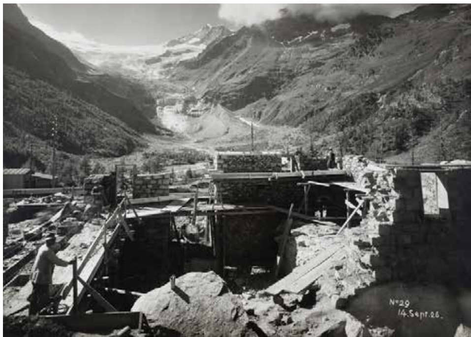
Preparazione delle fondamenta della centrale di Palù, realizzata contemporaneamente a quella di Cavaglia in soli 18 mesi fra il 1926 e il 1927. È alimentata dalle acque del lago Bianco. Sullo sfondo il ghiacciaio del Palù.
