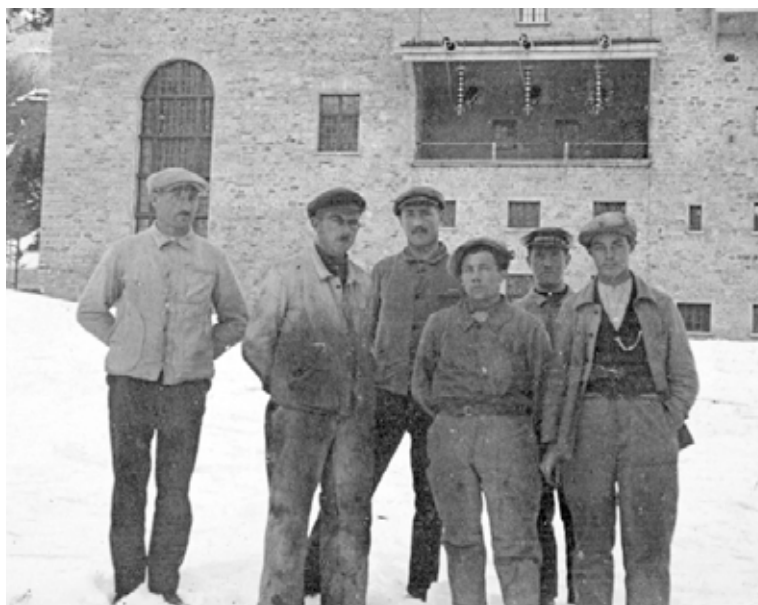
La centrale di Cavaglia in costruzione nell'ottobre del 1926. Sfrutta le acque del lago di Palù e del lago Bianco. I macchinari installati all'interno dell'edificio vengono fatti passare attraverso la grande apertura sulla facciata sud.
