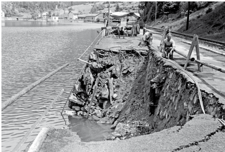
Cedimento di un tratto della strada cantonale che da Le Prese a Miralago costeggia il lago di Poschiavo, accanto ai binari della Ferrovia del Bernina. Fra il 1963 e il 1967 viene sostituita da una nuova strada costruita più in alto.
