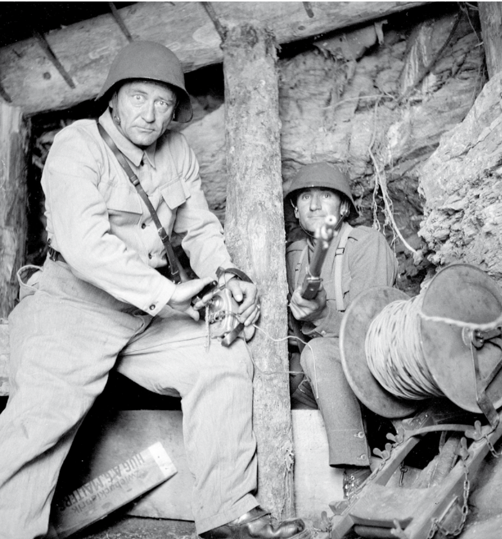
Postazione militare presso la strada sul lago di Poschiavo, luglio 1941. I soldati sono pronti a far saltare le mine poste sotto la carreggiata. AFS, E5792 1988/204 173.
